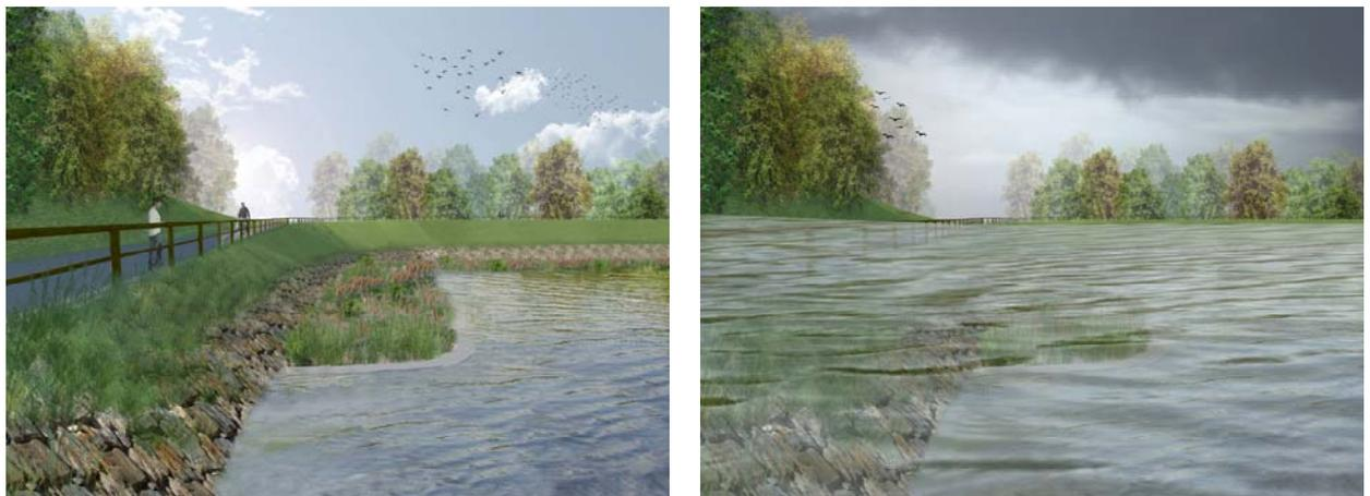
**Figura 2-7 – Visuali interne alle vasca (fotoinserti) che sostituiscono le immagini numero 17 della figura 5-6. A sinistra la visuale del bacino con acqua permanente. A destra la vasca in fase di piena (in questi periodi alcuni percorsi intorno alla vasca non saranno accessibili).**
