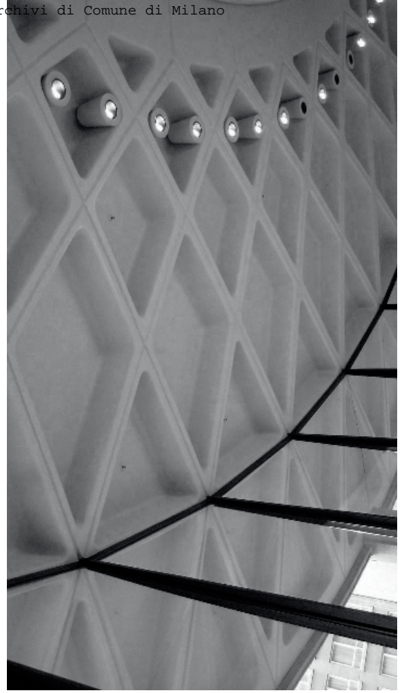
Solai in cemento armato piattati e nervati
