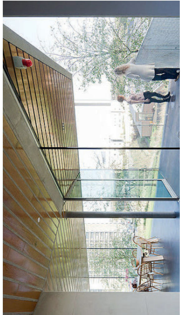
Solai in cemento coadiuvati da nervature strutturali in legno
