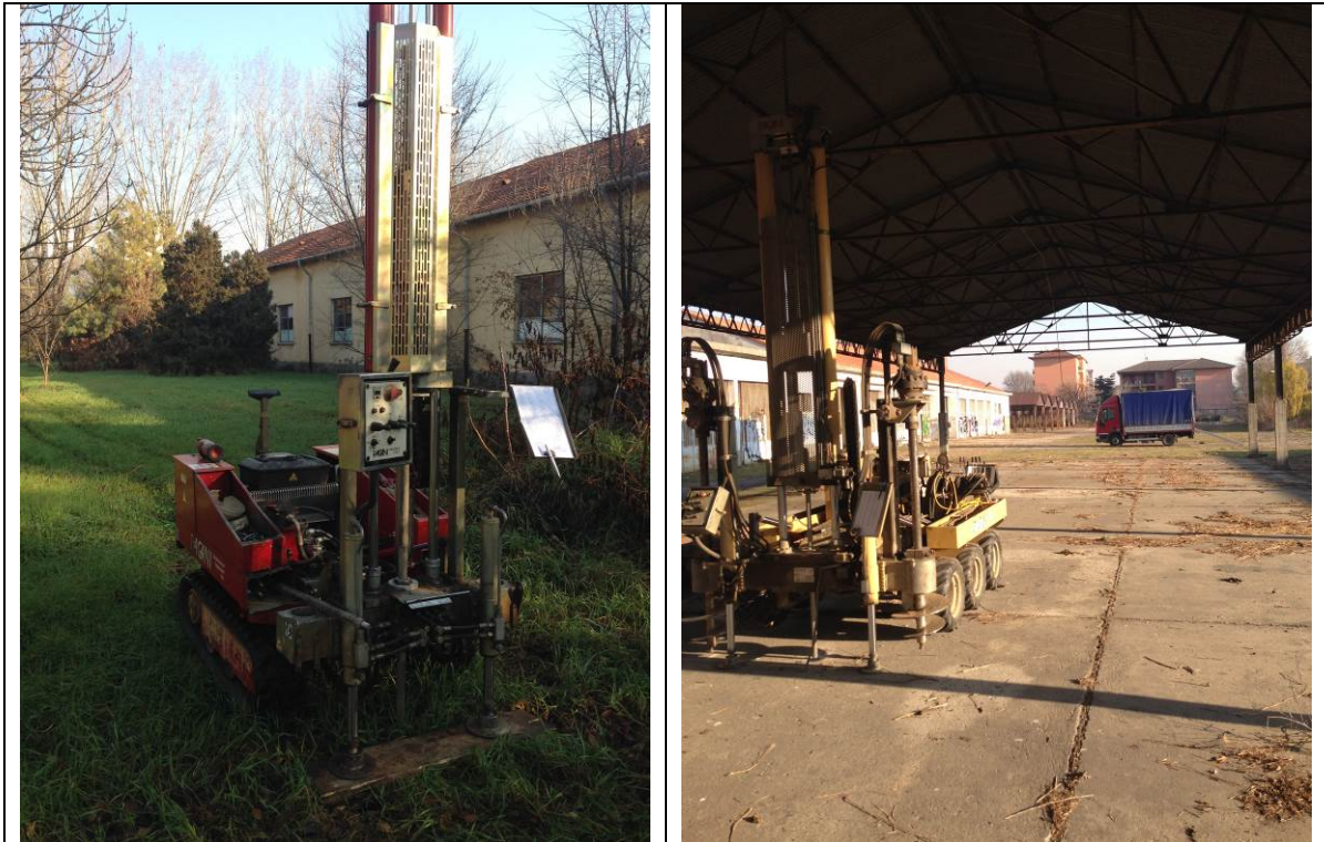
Figura 4.2 Esecuzione delle prove penetrometriche
