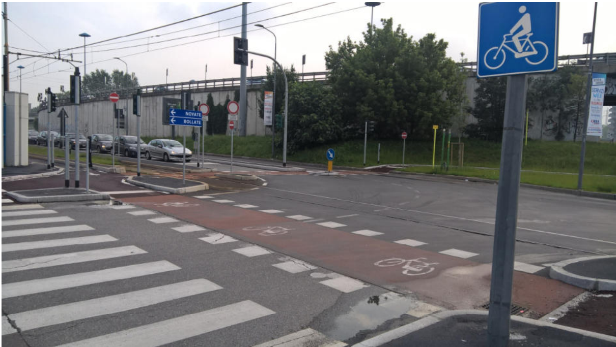
Foto 01 – Intersezione 1 – vista intersezione da via Novate
