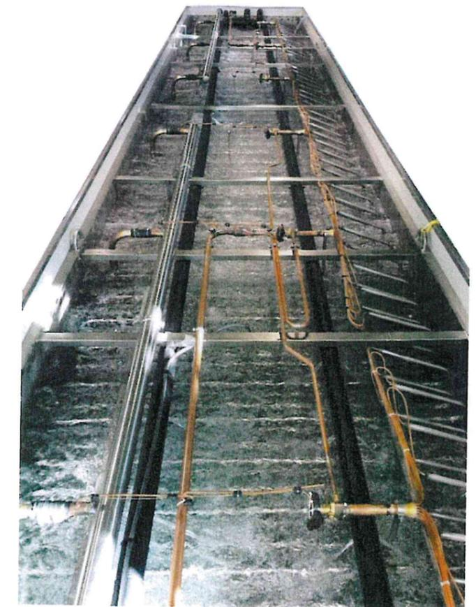
Fig.09: Interno di una vasca gelida
