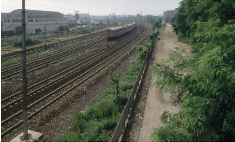
Lo Scalo di San Cristoforo
