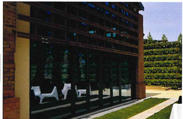
Cascina Triulza – Vista della ex-Stalla prima (sx) e dopo (dx) l'intervento di chiusura con tamponamenti vetrati trasparenti
