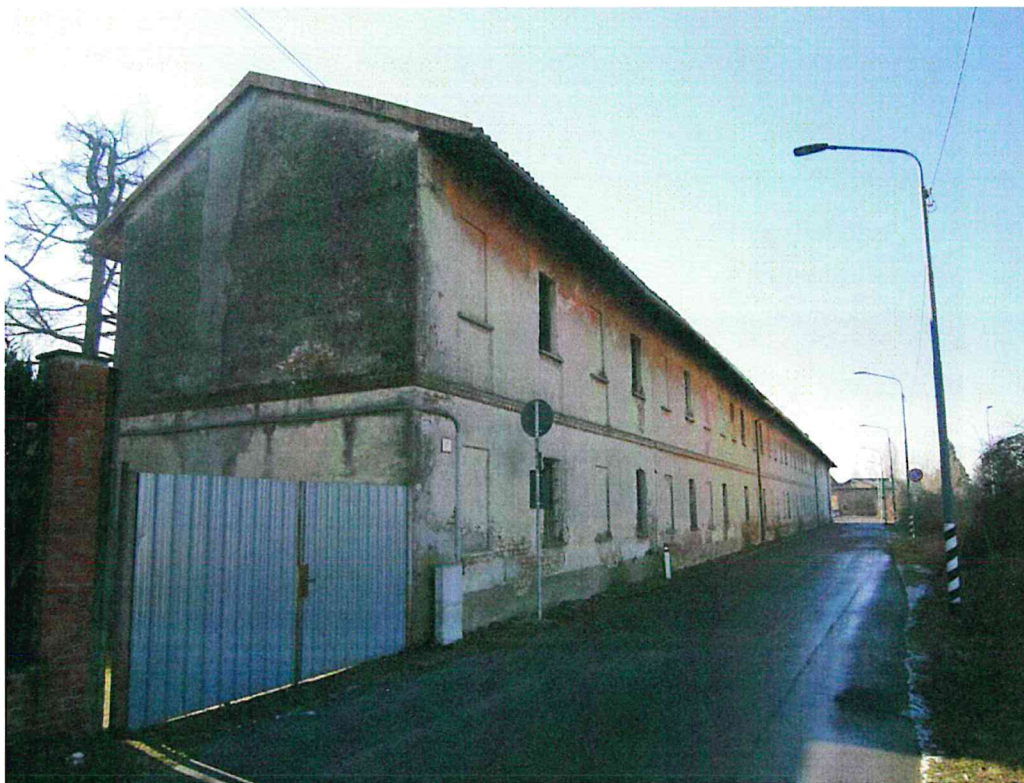
Vista esterna edificio salariati
