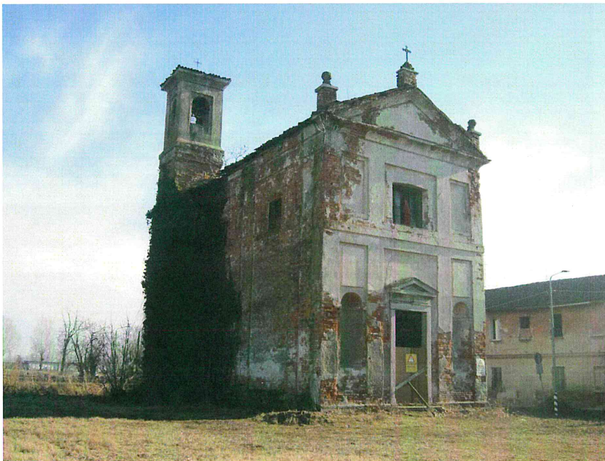
Particolare della facciata principale della ex chiesetta di San Carlo
