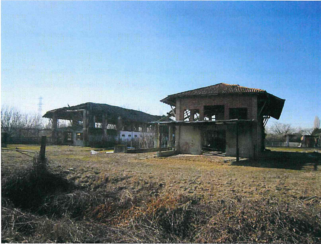
Vista interna delle corti da cui emerge lo stato di degrado degli immobili
