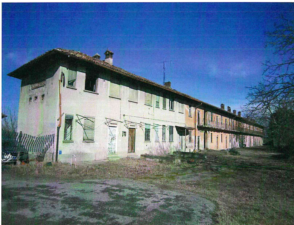
Vista interna edificio salariati
