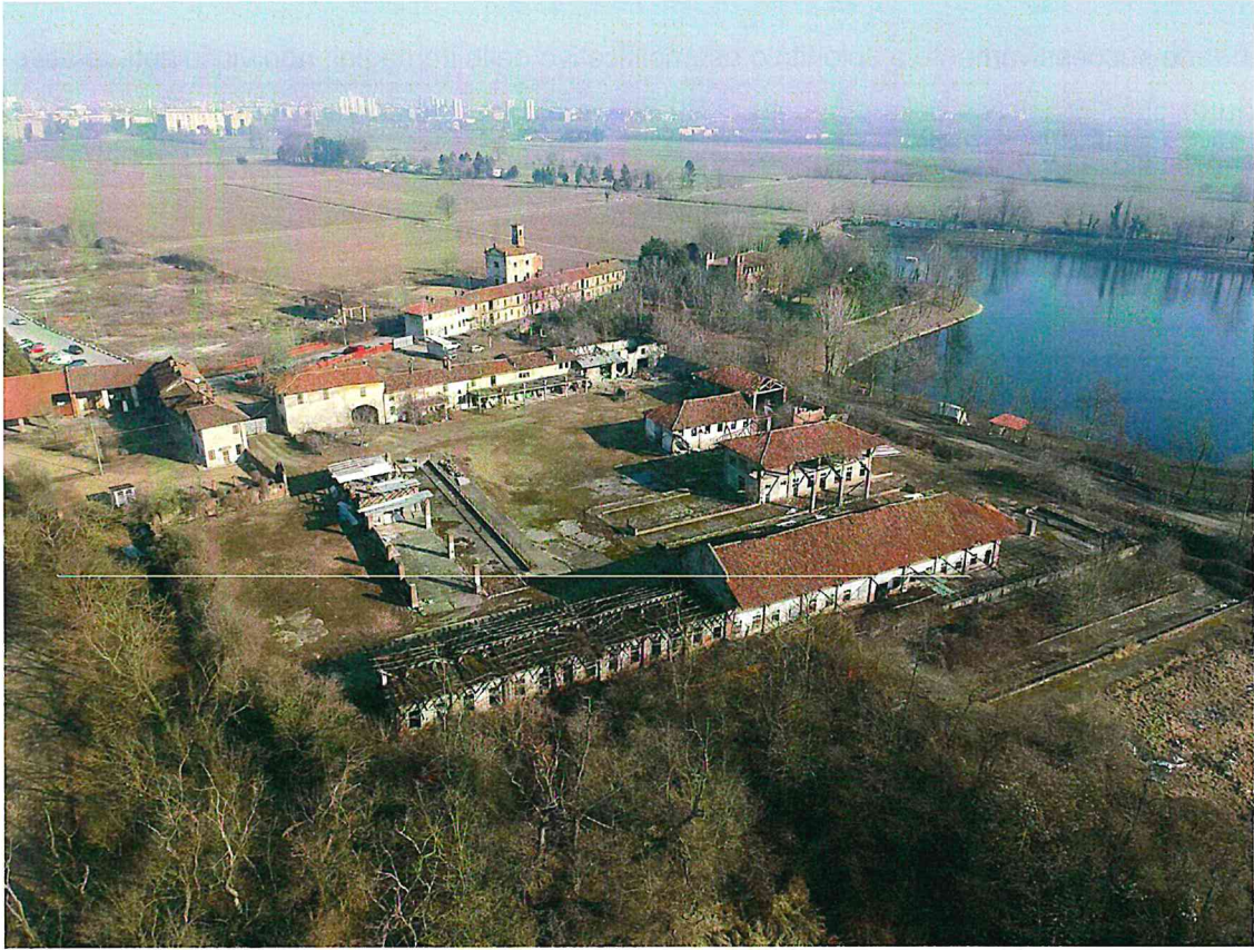
Vista sud: stato di fatto
