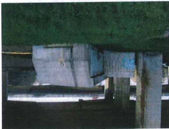
Vista da monte della sezione di ingresso della seconda trave in cemento armato (sinistra) e spessore della stessa dove si possono notare le due strutture accoppiate (destra).
