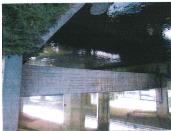
Vista da monte della sezione di ingresso della seconda trave in cemento armato (sinistra) e spessore della stessa dove si possono notare le due strutture accoppiate (destra).
