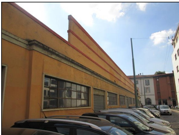
Stato attuale - vista esterna (Via Fosse Ardeatine)
